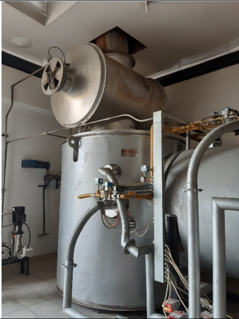
Foto No. 3 sistema de control
